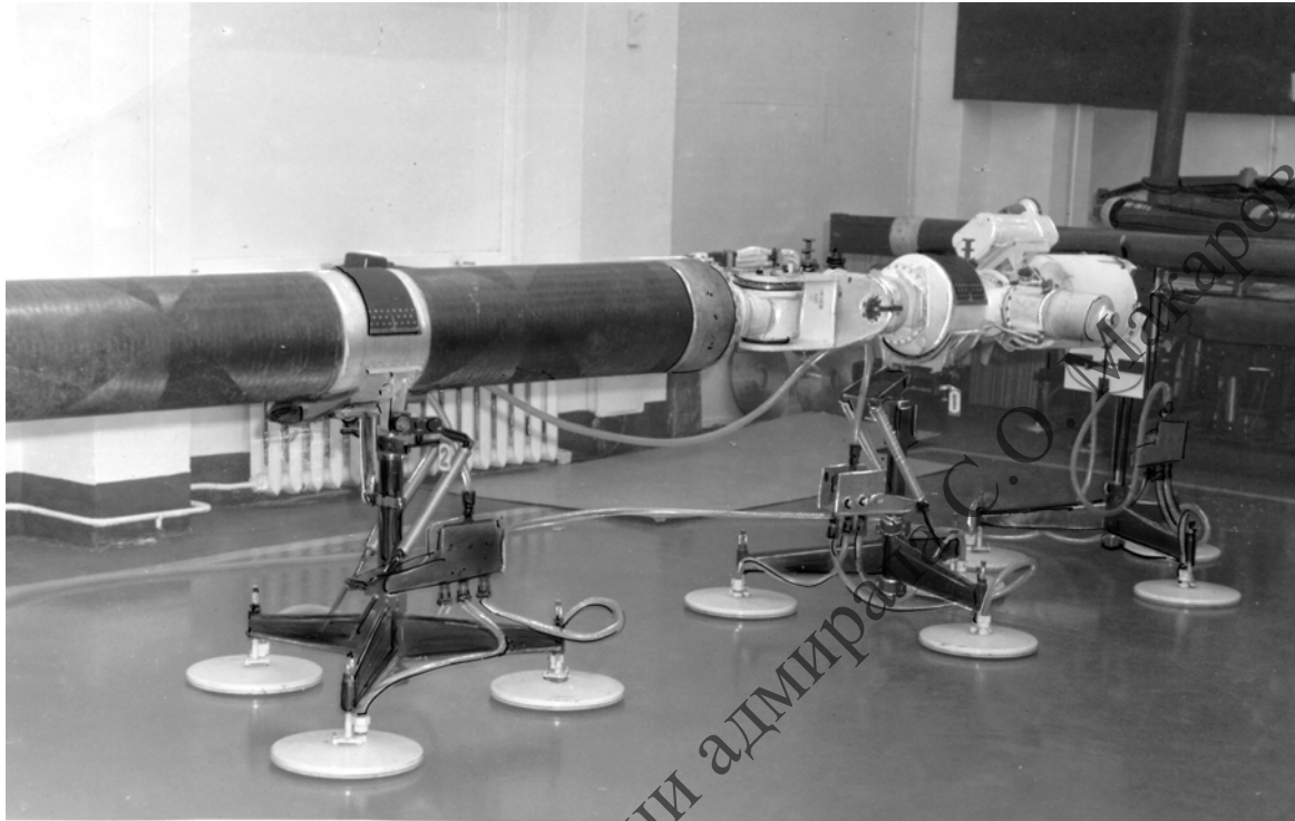
Рис.3.19. Звено манипулятора, перемещающегося на воздушных подушках.
