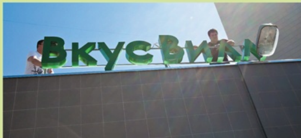
Открытие первого «ВкусВилла» по адресу Большая Спасская, 8. Вывеску монтировали в день официального открытия
