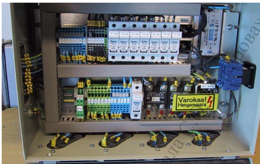
Рисунок 1.20 - Компоненты матроники в «боксе питания»: 90VDC, 24VDC, 0V в WECS - 9520
