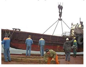
Всю технику спускают на воду тяжеловесными стрелами на заранее подготовленных стальных стропах (рис. 6.78). За баржи, катера и тракторы заводят растительные тросы, чтобы с их помощью можно было на весу развернуть в нужную сторону каждый из указанных тяжеловесных грузов.
