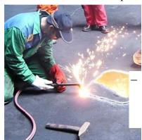
При нахождении судна в море производство огневых работ допускается только с разрешения капитана, о чем делается запись в судовом журнале.
