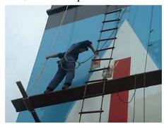
Тировка такелажа и покраска мачт производятся с беседок, укрепленных на *горденях*. Гордень должен быть основан из надежного и качественного троса, а у места крепления его на палубе в течение всего времени работы должен находиться наблюдающий. Перед подъемом людей гордень должны быть испытан. Для этого беседку с помощью горденя приподнимают на 30 – 40 см над палубой, *ходовой конец* крепят на *утке*. В беседке помещаются
