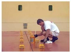
Обычные кисти. Они незаменимы при работе в помещениях с большим количеством оборудования, приборов, проводов, а также в труднодоступных пространствах, где затруднительно устройство вентиляции и ограничена свобода маневрирования с краскораспылителями безвоздушного типа, требующими особой осторожности при окрашивании.
