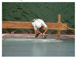
Стальную поверхность от ржавчины и окалины очищают пневматическими молотками или кирками, избегая повреждения поверхности насечкой стали, усиливающей коррозию. Окончательно стальную поверхность обрабатывают пневматическими или ручными стальными щетками, удаляя остатки (налет) ржавчины и следы старой краски.
