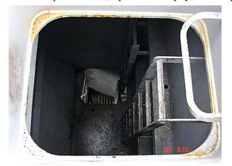
Рис. 5.11. Жесткий вертикальный трап
