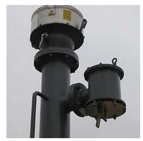
Рис. 6.89. Клапан давления/вакуума
