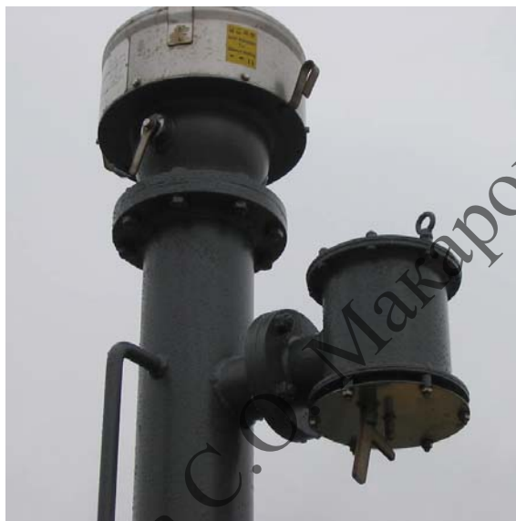
Рис. 11.14. Клапан давления/вакуума
