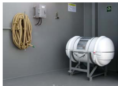
Плот, установленный в удаленном месте
