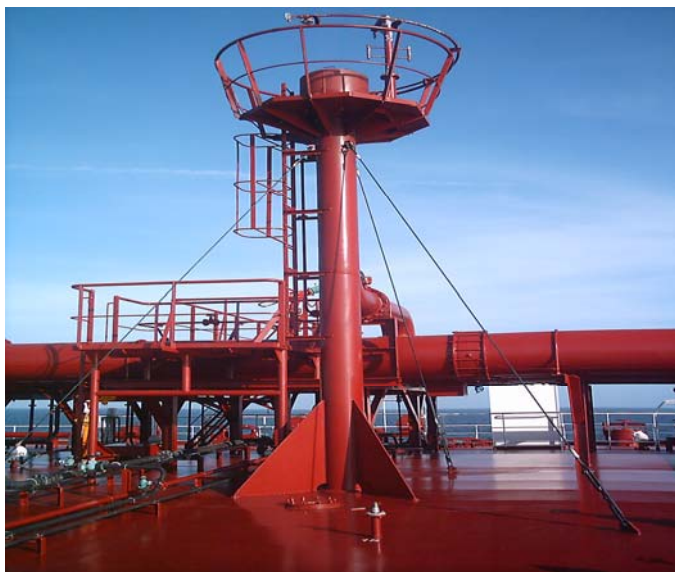
Рис. 11.13. Общая газоотводная труба
