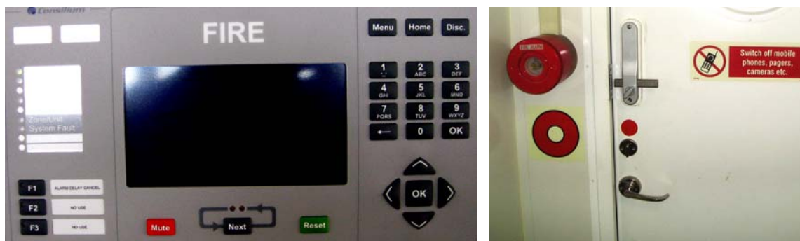
Рис. 13.7. Пульт пожарной сигнализации на мостике и пожарный извещатель
