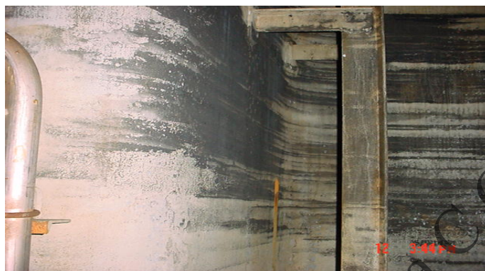
Рис.11.12. Промежуточное состояние грузового танка в процессе мойки в инертнизированной среде (на переборке сажа от инертных газов)
