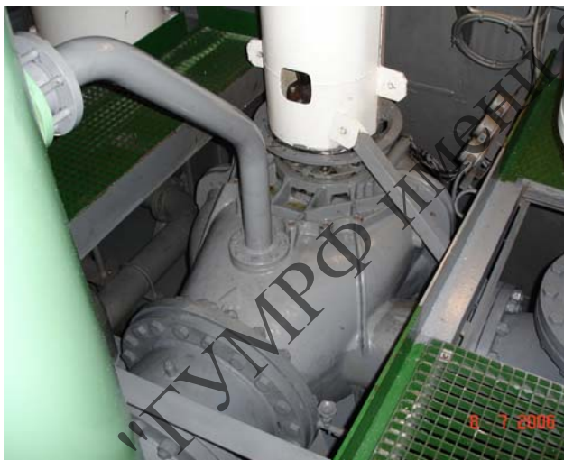
Рис. 11.9. Грузовой насос
