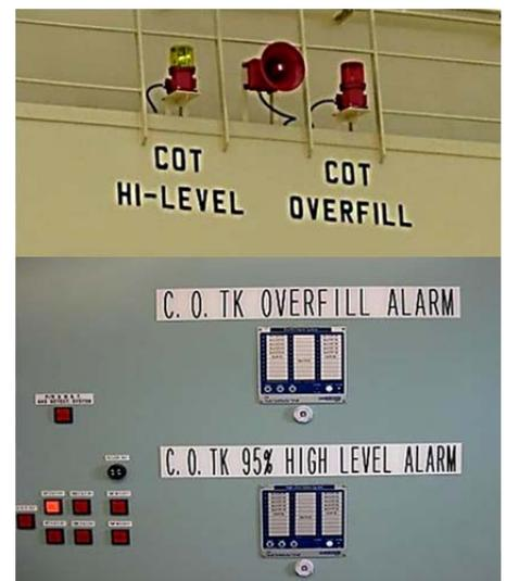
Рис. 11.26. Датчики заполнения грузовых танков
