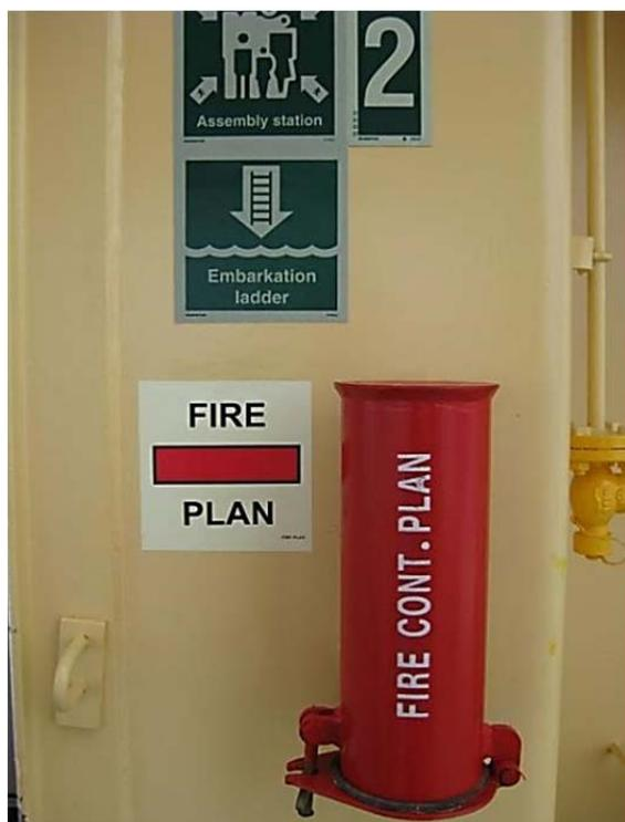
Рис. 3.38. Пожарный план судна
