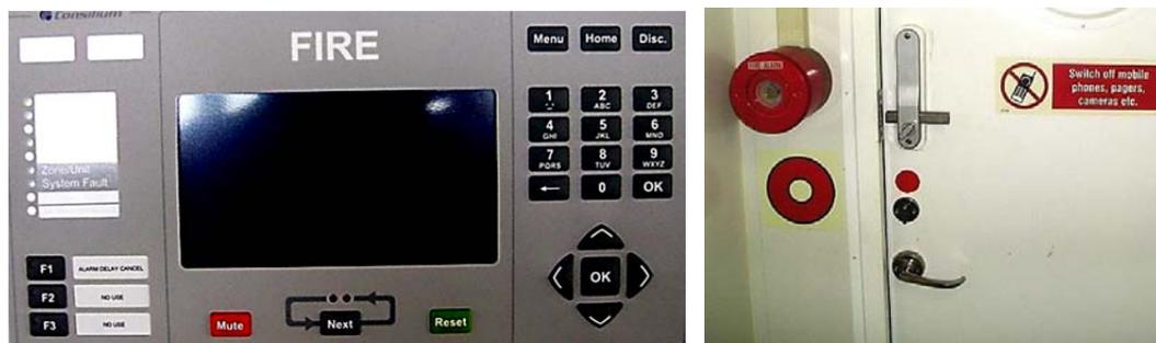
Рис. 14.11. Пульт пожарной сигнализации на мостике и пожарный извещатель
