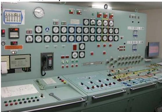
Зачистная система должна быть оборудована приборами контроля: счетчиками, манометрами, которые должны иметь средства дистанционного показа контролируемых параметров в посту управления грузовыми операциями (ПУГО).
