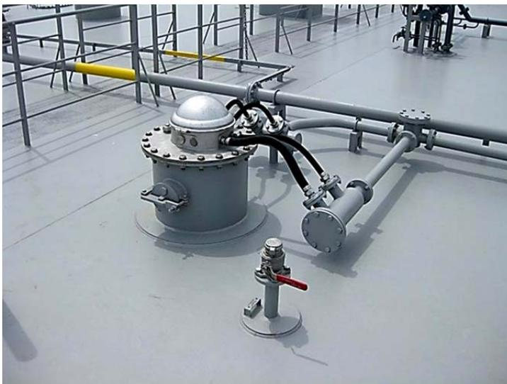
Рис. 11.25. Датчик радарного типа на палубе танкера
