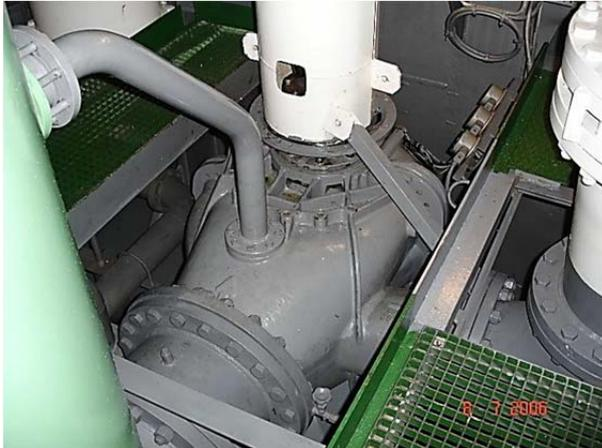
Рис. 11.6. Грузовой насос
