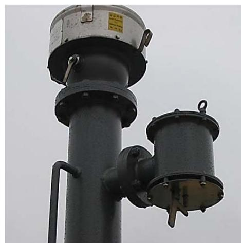
Рис. 11.11. Клапан давления/вакуума
