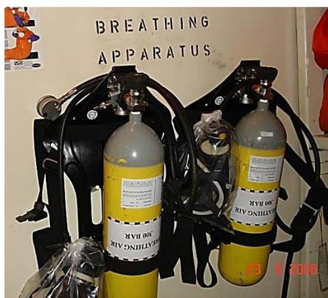
**Изолирующие дыхательные аппараты** на сжатом воздухе АСВ-2 ДРЕГЕР предназначены для защиты органов дыхания и зрения человека при работе в атмосфере, непригодной для дыхания (повышенная концентрация отравляющих веществ или обедненная кислородом атмосфера) и при работе под водой на глубине до 20 метров.
