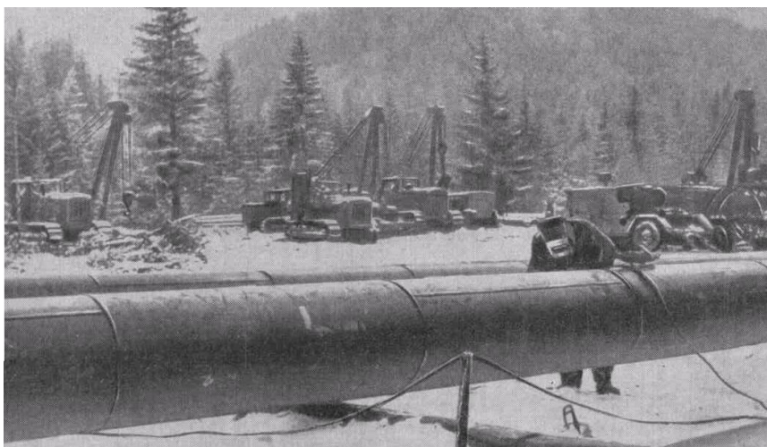
Рисунок 6.1 – Строительство линейной магистрали наземного трубопровода
